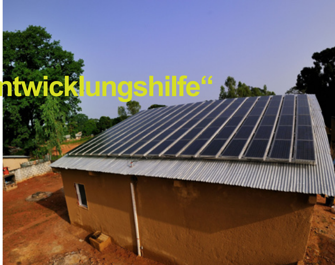
Der Energiekiosk dient den Dorfbewohnern als Tankstelle für Solarstrom. Ihr Pächter verdient damit Geld.
